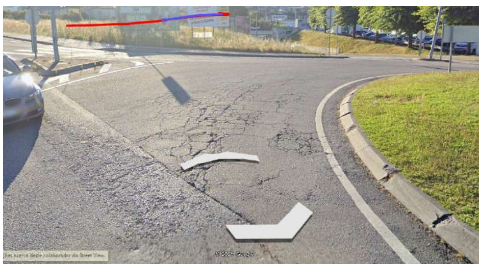
Fissuração tipo pele de crocodilo;
