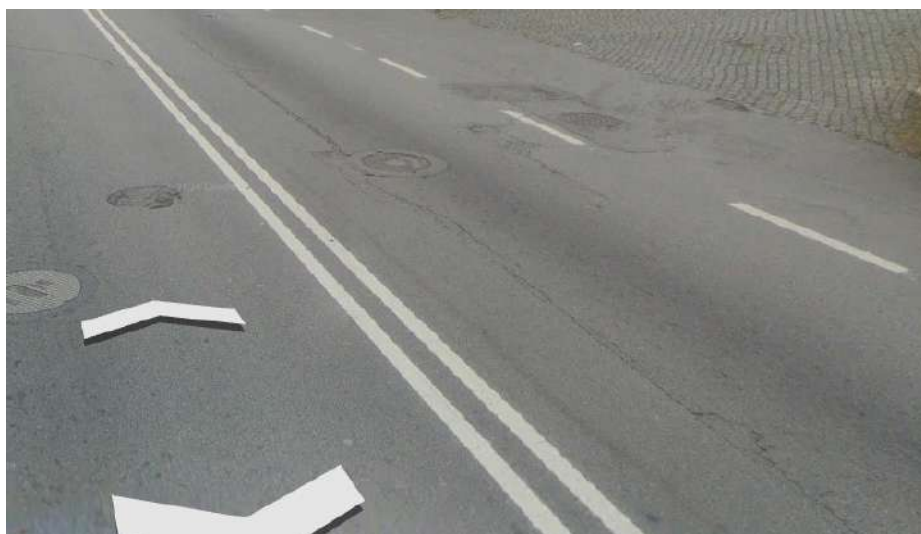
Fissuração longitudinal (generalizado)
