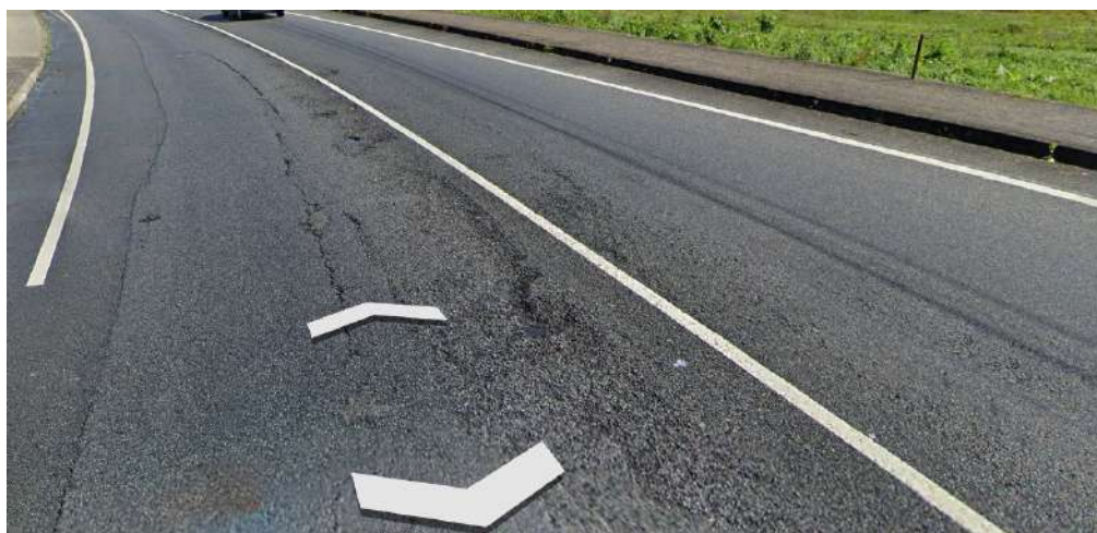
Desgaste da camada superficial (pontual)
